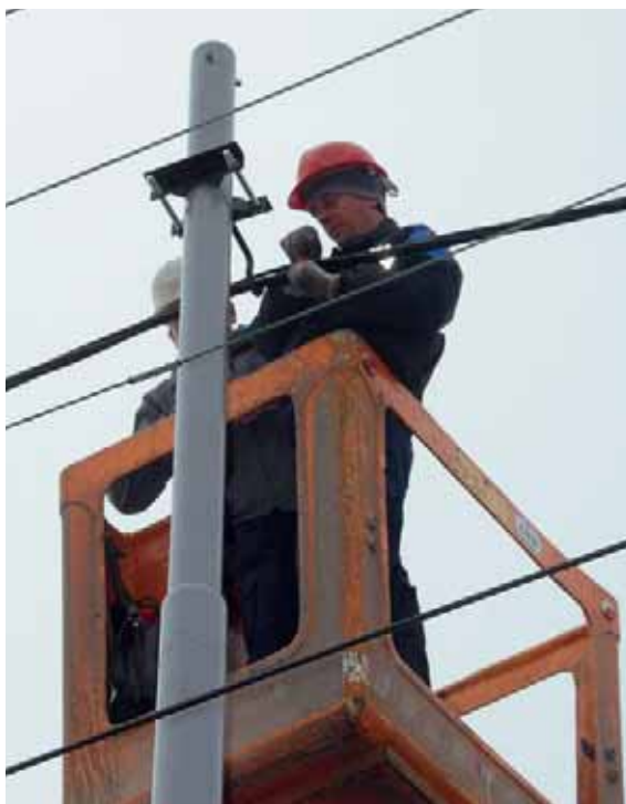
Радови у Шапцу на измештању водова
