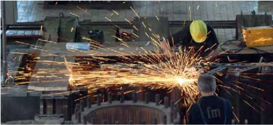
У току активности за наставак капиталног ремонта блока Б 2
