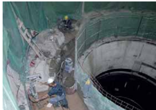
Демонтирана електромашинска опрема
