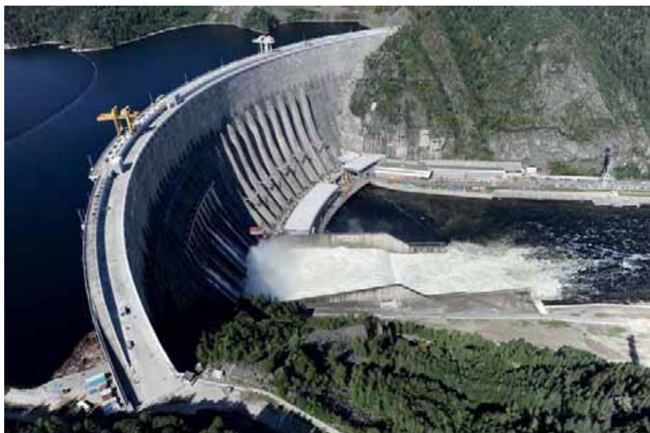
Највећа руска хидроелектрана: „Сајано Шушенскаја“
