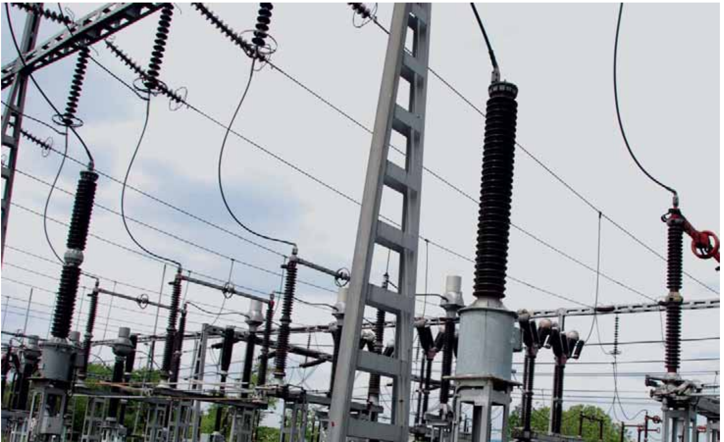
Неопходно је да се усагласе планови изградње ЕПС-а и ЕМС-а: ТС 110 kV „Београд 8”
