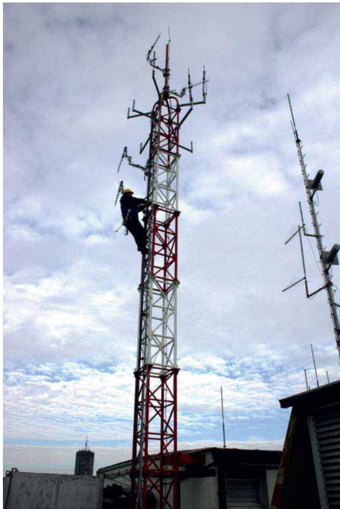
Бржа локализација квара у ТС 10/0,4 kV
