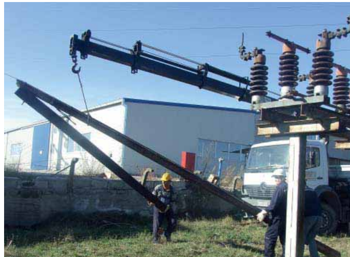
Отклоњена оштећења на стубовима далековада
