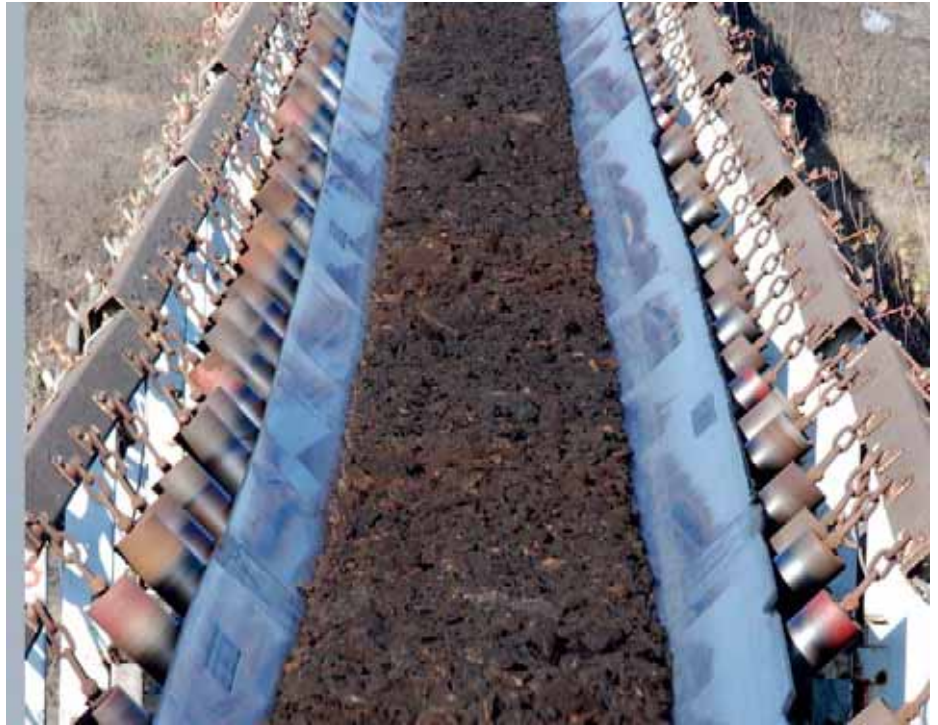
Људски фактор, углавном, узрок повреда на раду: транспортне траке „Тамнава Источно поље“
