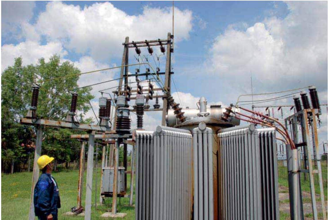
У току радови и на санацији ТС 110/20 kV „Нови Бечеј“
