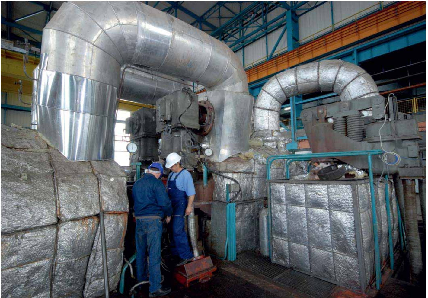
Реконструкција турбине омогућила и повећање снаге електричног дела
