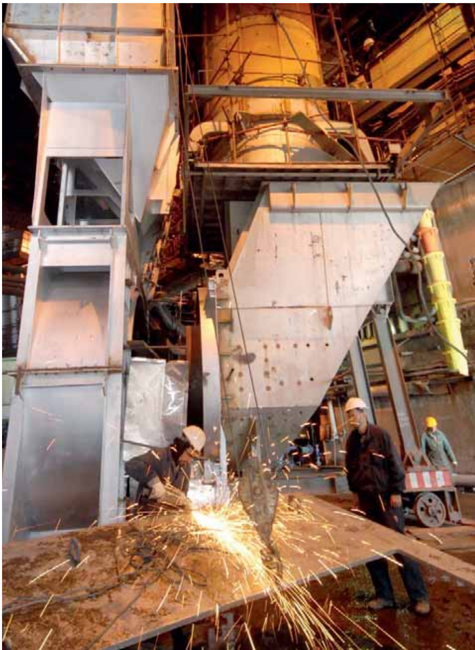
При крају и радови на котлу
