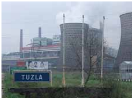
Обустављена изградња новог блока у ТЕ „Тузла“
