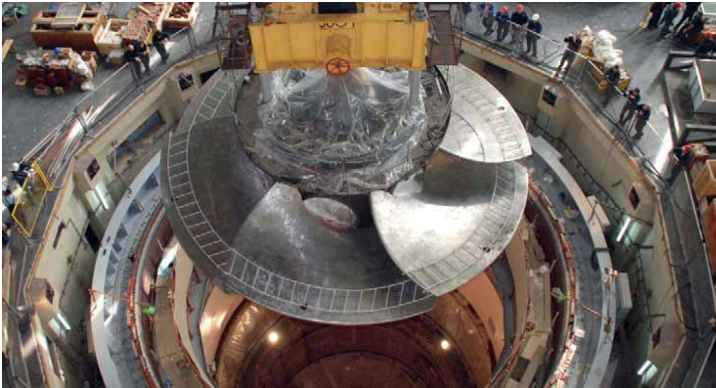
Конечно спуштање радног кола у лежиште представља и почетак монтаже турбинског вратила
