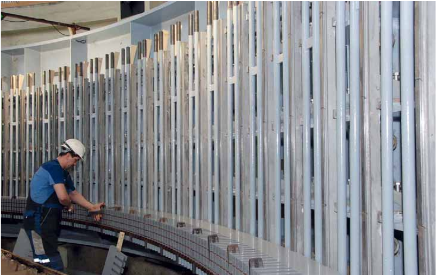
Монтажа статора агрегата убудуће на монтажном блоку
