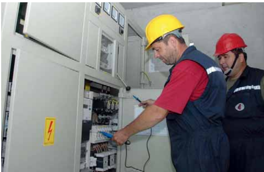
Нове ТС растеређују чворишта потрошње електричне енергије: ТС 20/0,4 kV Житиште
