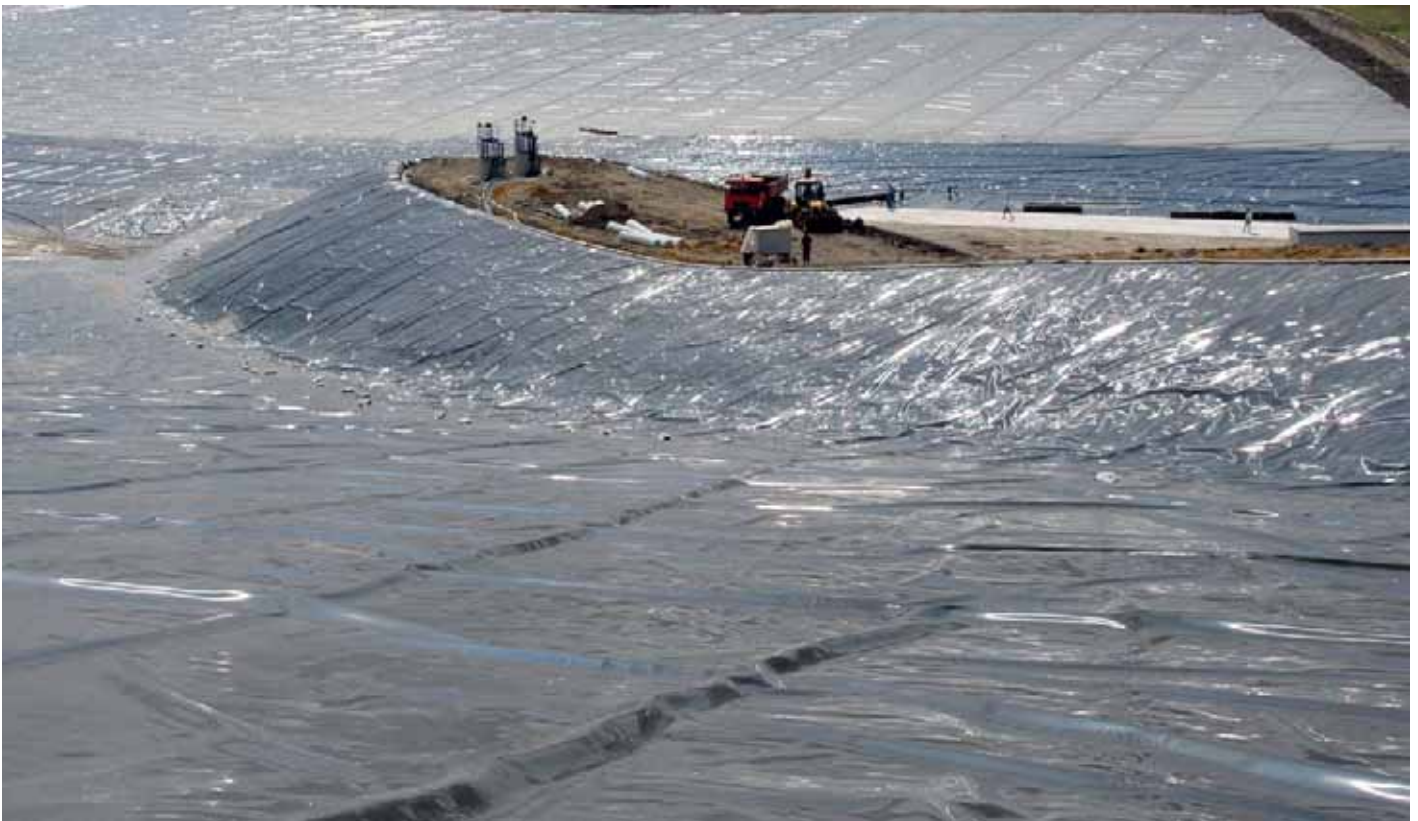
Цео систем за одлагање пепела и шљаке на копу „Ћириковац“ пројектован да има и стопостотну резерву
