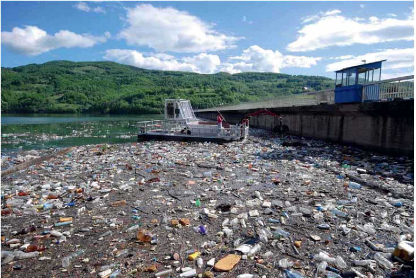
Велики наноси отпада у језеру покварили улазни затварач првог агрегата
