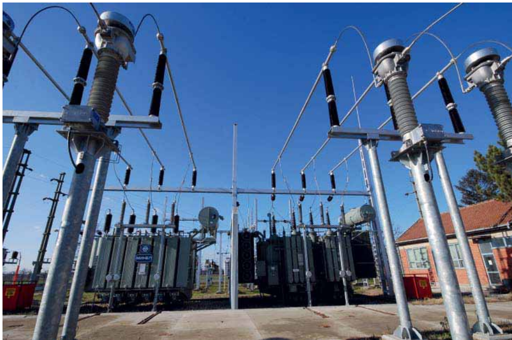
Јачање енергетских објеката за потребе привреде: ТС „Рума 2“
