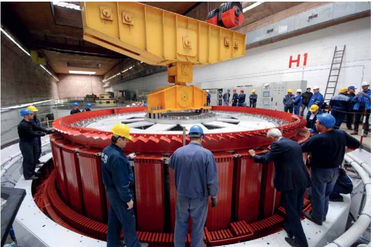
Монтажа ротора израђеног по новој технологији
