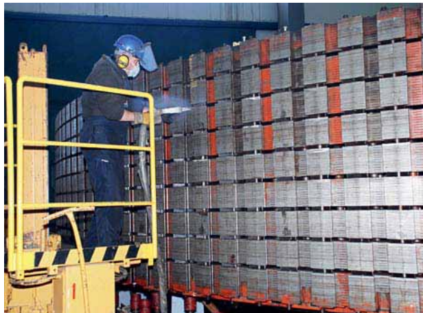
Чишћење ротора шестог агрегата
