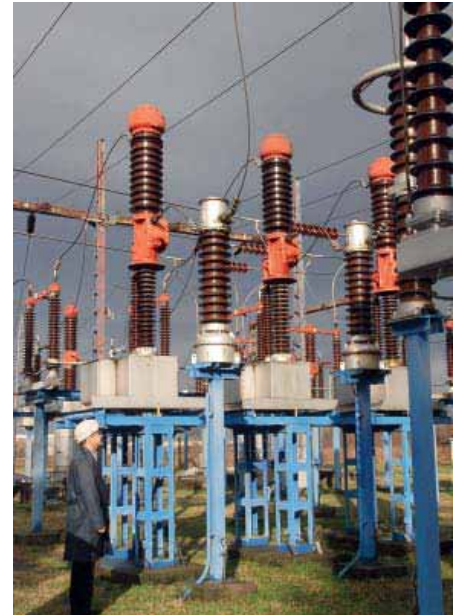
Добро снабдевање купаца захваљујући и ТС 110/35 kV
