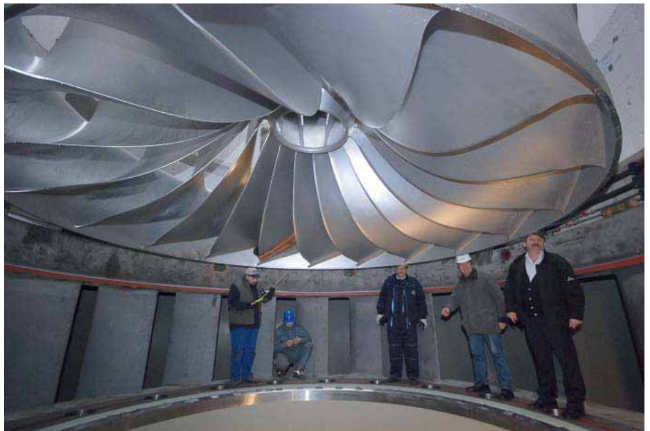
„Маневрисање“ теретом од 40,5 тона који мора да се спусти у простор истоветних димензија веома компликована операција
