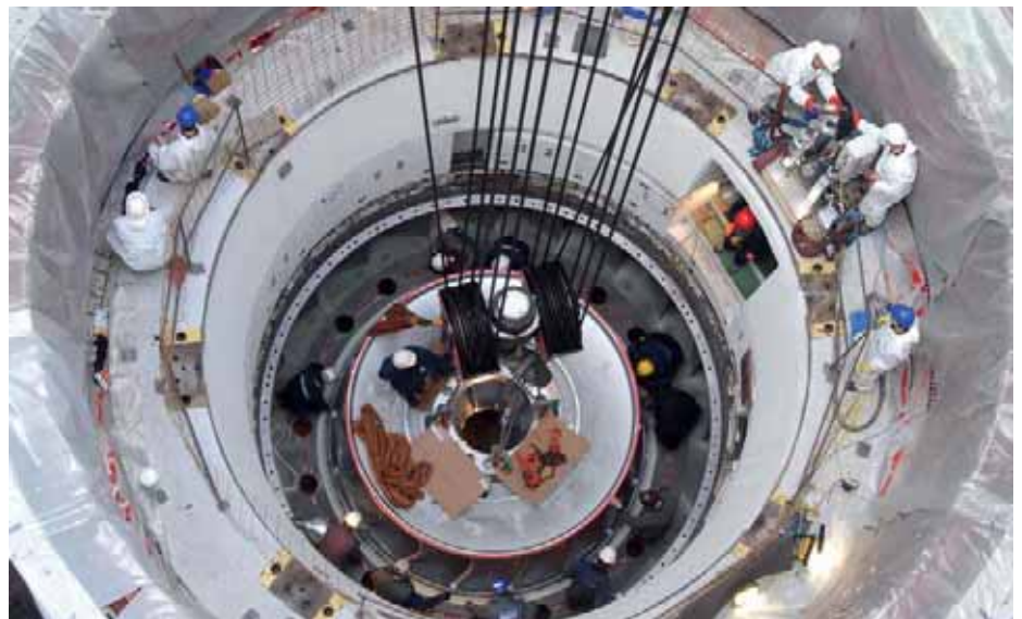
Замена опреме у агрегату 1 ХЕ „Бајина Башта“ у пуном јеку
