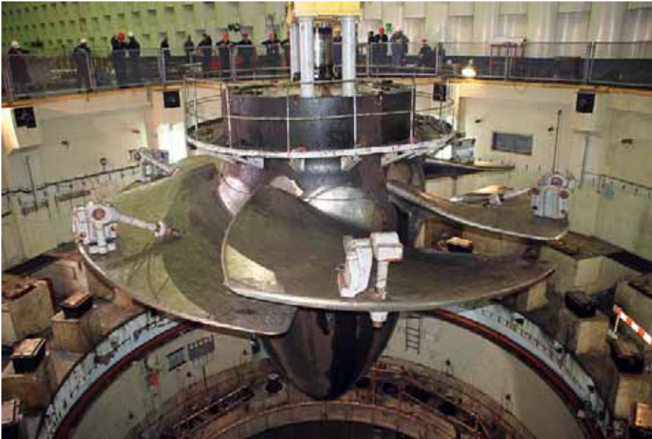
Новe турбине у ХЕ „Ђердап 1“ са лопатицама мање тежине и нових профила
