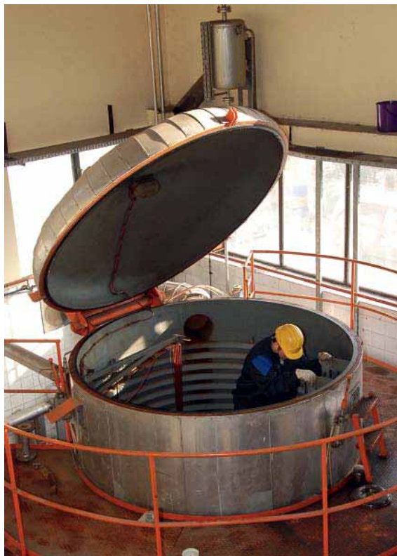
Раритет у ЕПС-у: Комора за сушење трансформатора
