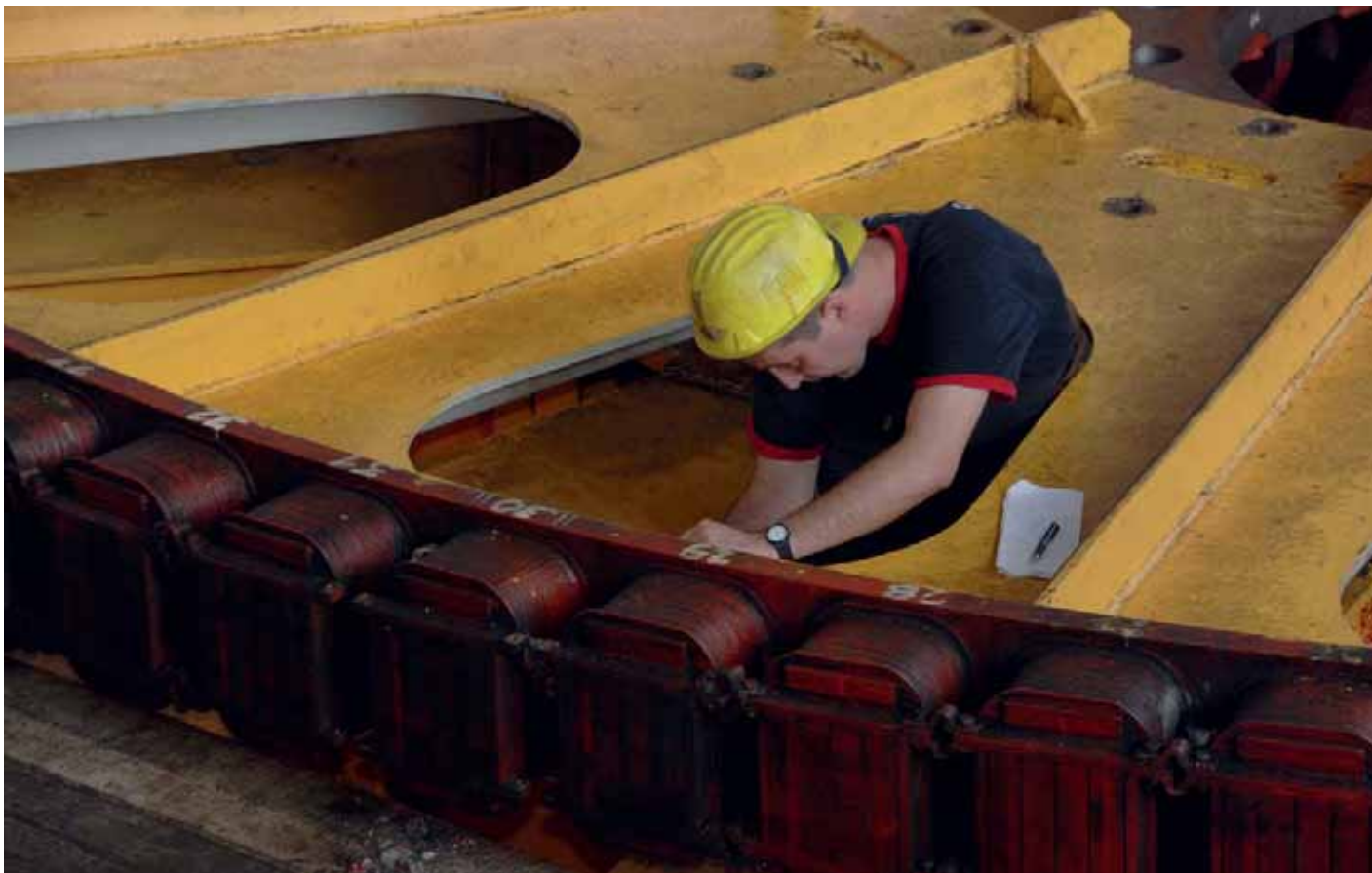
ХЕ „Ђердап 1“ : Демонтажни радови и у сопственој режији
