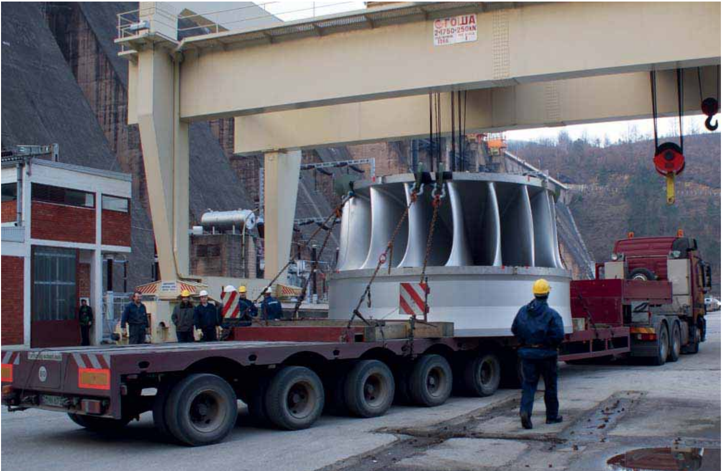
Нова радна кола у сва четири агрегата ХЕ „Бајина Башта“
