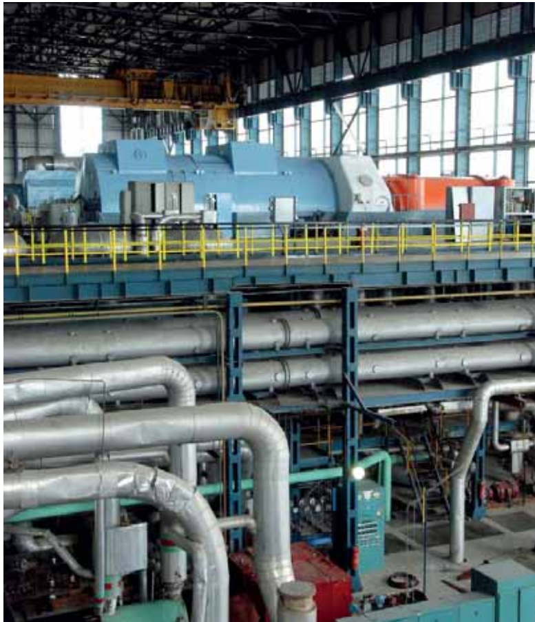
ТЕ-ТО „Нови Сад“: комбинованом производњом до економичне топлотне енергије
