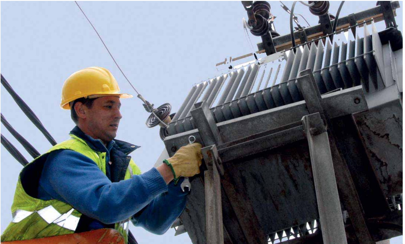
Монтажа трансформатора у ТС Погона Крњача
