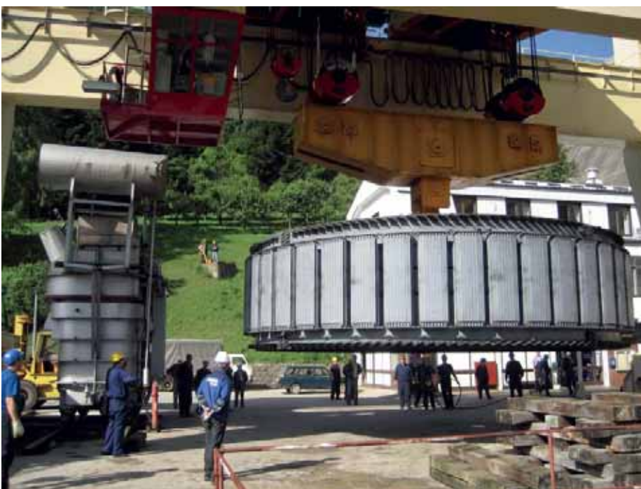
Остаје стари ротор, али се мењају намотаји свих полова
