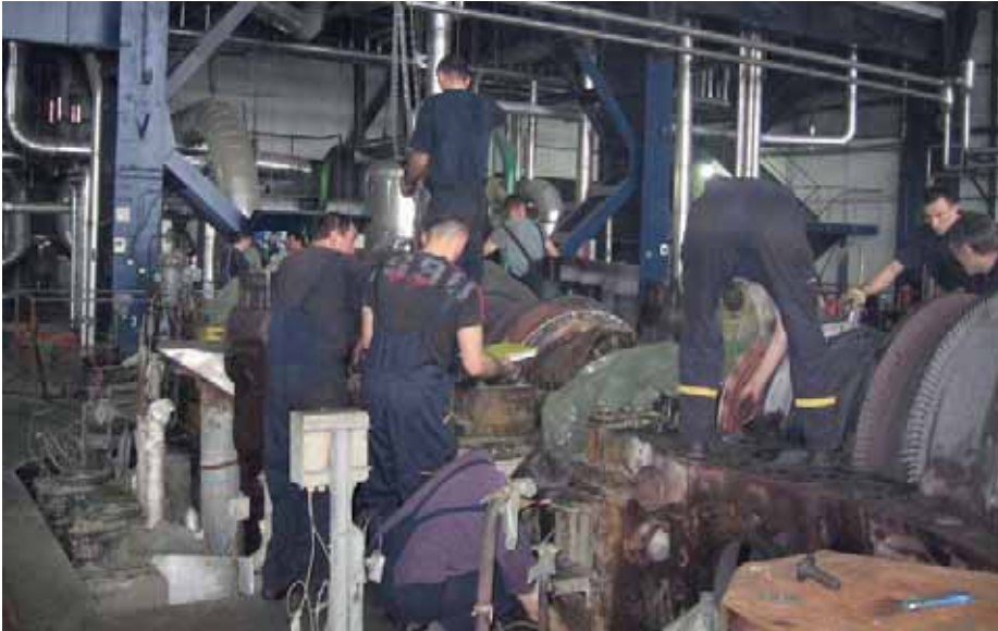
Завршни радови на ремонту турбоагрегата
