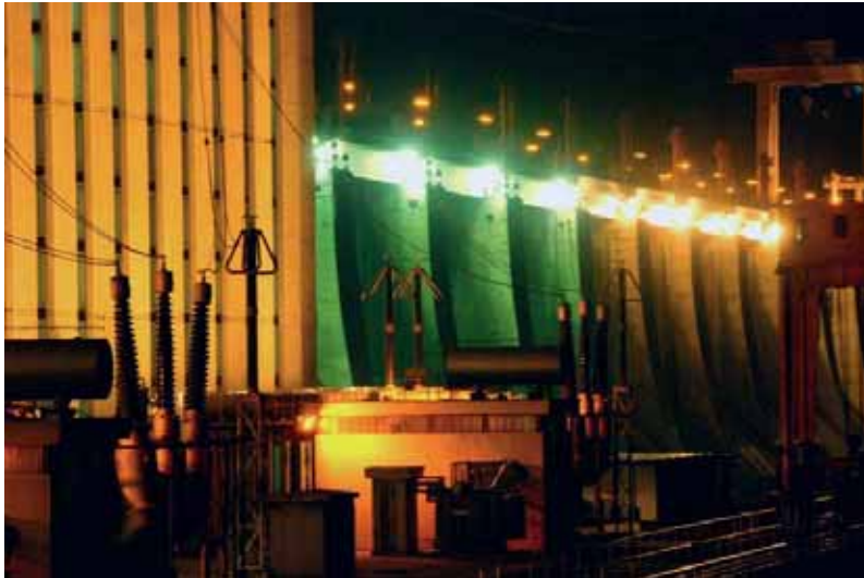
Један агрегат у ремонту, пет граби воду: ХЕ „Ђердап 1“
