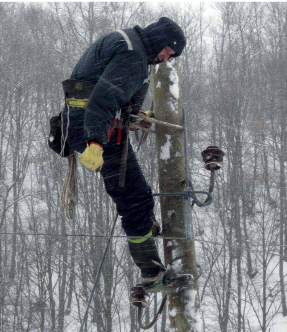
Под тежином снега стабла падала и кидала проводнике и стубове
