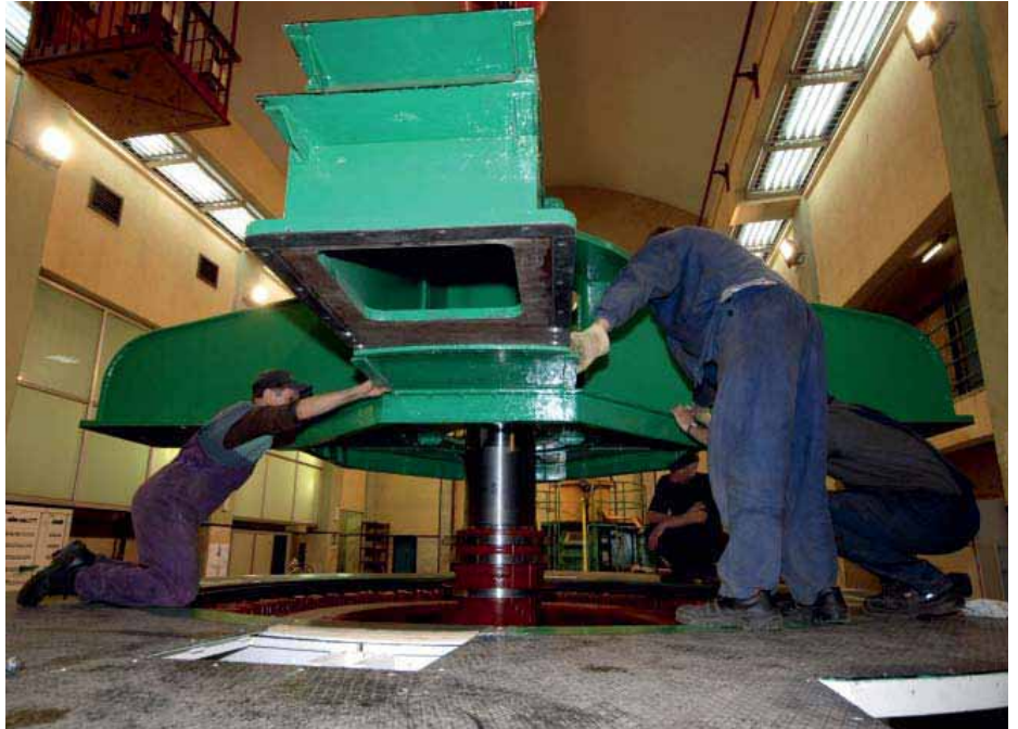
Постављање крста генератора
