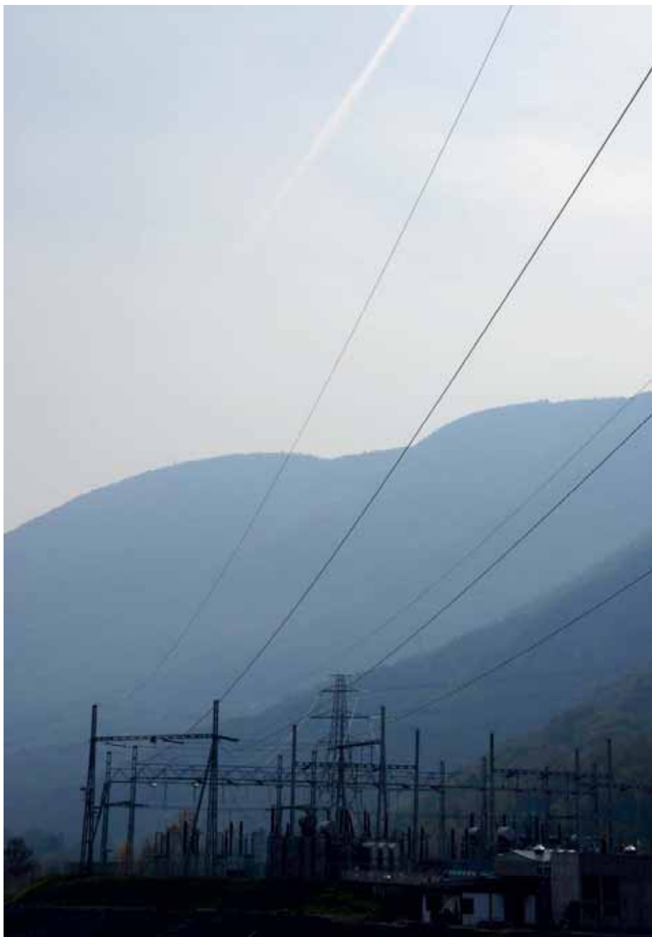
Далековод до електране иде преко Дрине: ХЕ „Бајина Башта“
