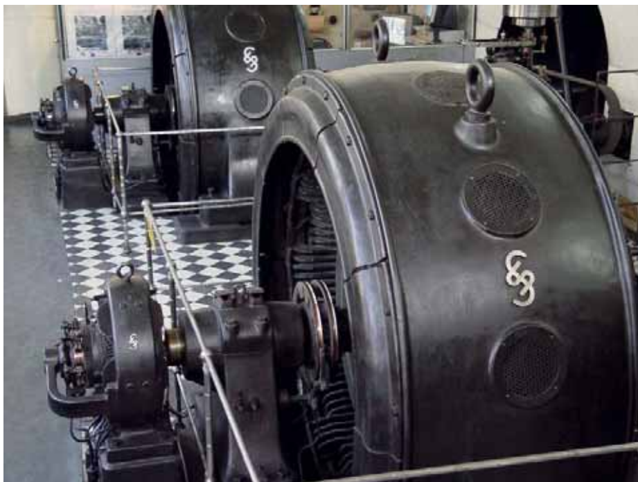
Генератор у ХЕ „Сићево“ на Нишави
