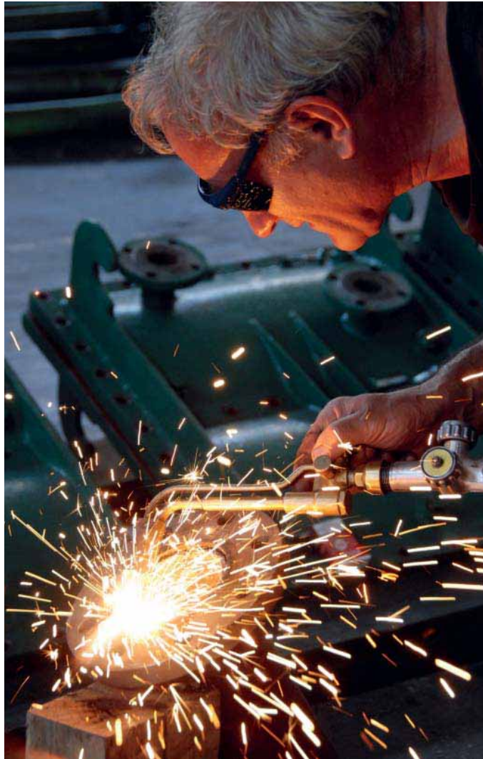
ХЕ „Ђердап 1“: ремонти у пуном јeku
