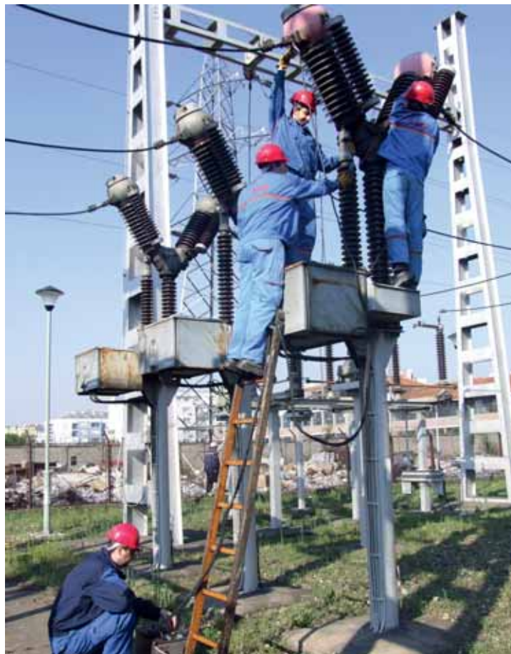
Најобимнији радови на реконструкцији 35 kV надземних водова
