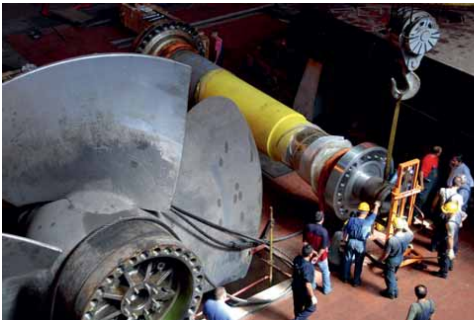
Успешно реализоване операције спуштања вратила и радног кола турбине у лежишта
