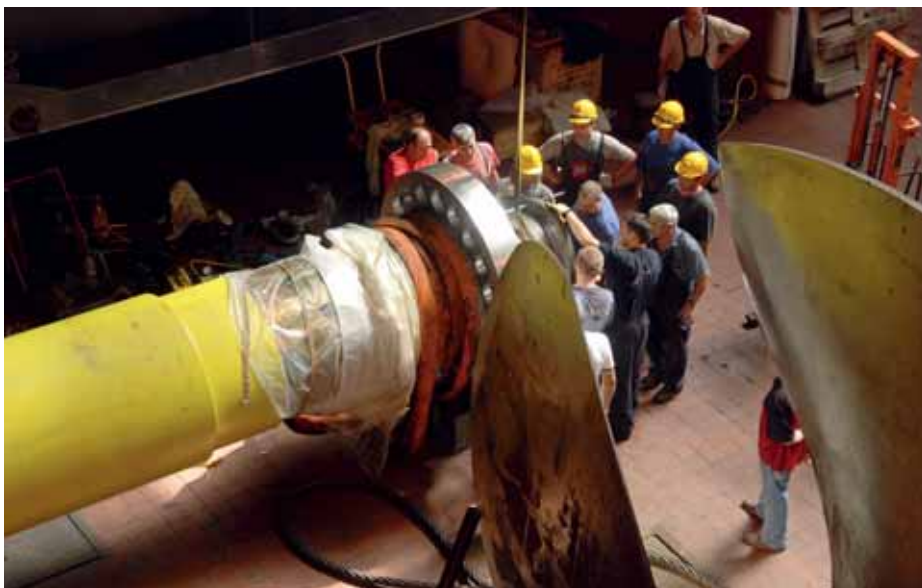
Успешно реализоване операције спуштања вратила и радног кола турбине у лежишта
