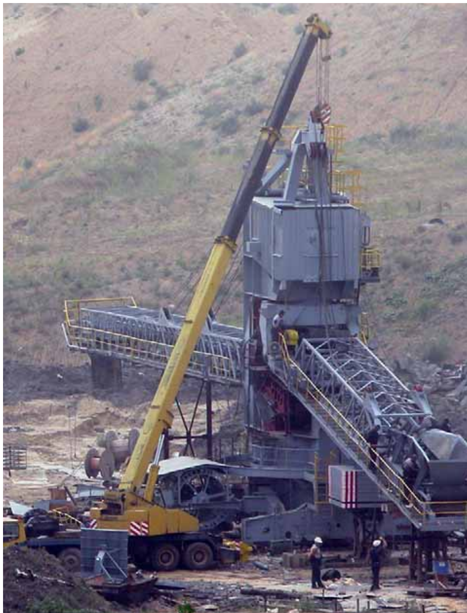
Завршена носећа конструкција новог багера
