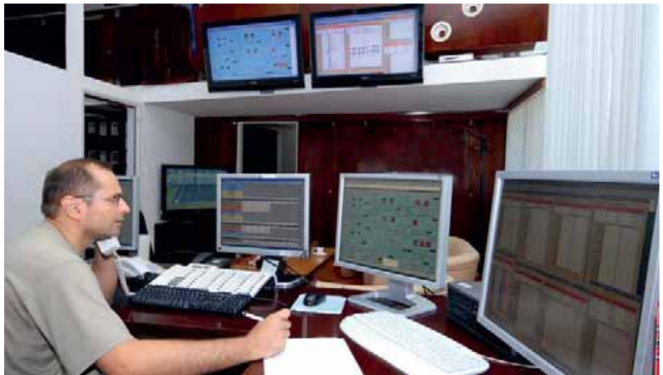
На екранима су подаци који помоћу SCADA система стижу из електрана
