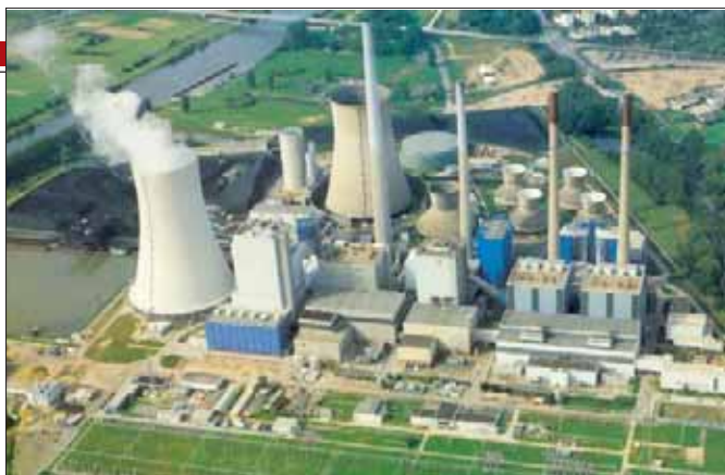
Струје све мање: неопходна изградња нових објеката
