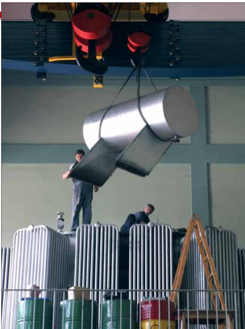
Најважнији послови у ХЕ “Кокин Брод”: ремонт трансформатора и замена магнетног језгра и намотаја
