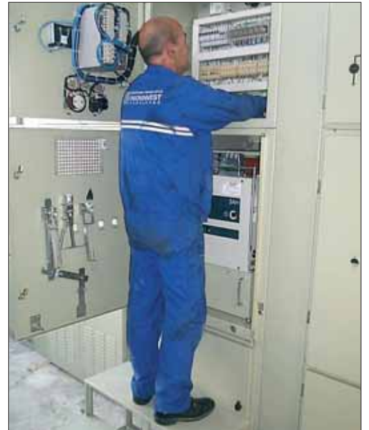
У току осавремењавање управљања у ТС и то локално и даљински
