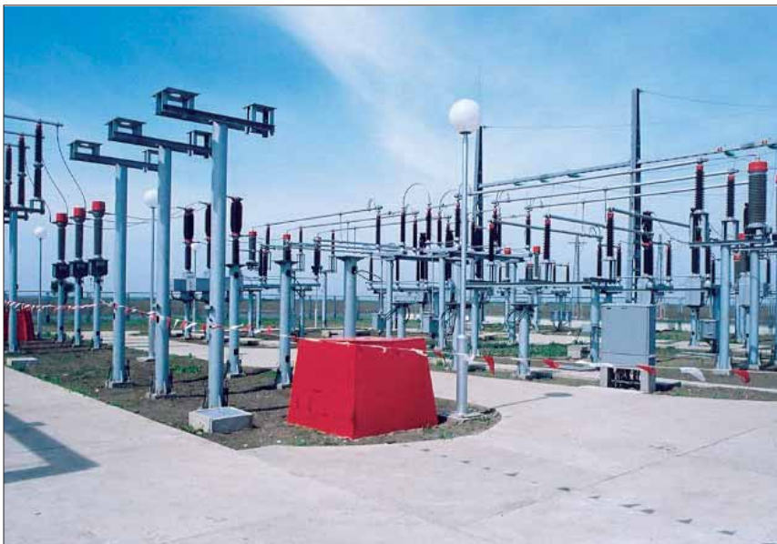
У току реновирање трафо-станица 110 kV
