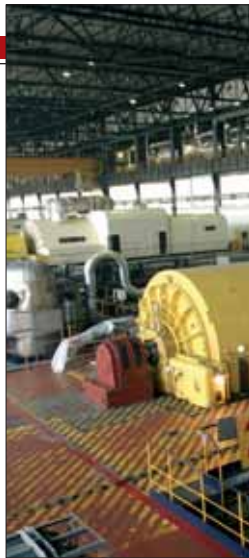
Ремонти се већ "исплаћују": са капиталног ремонта блока А-2
