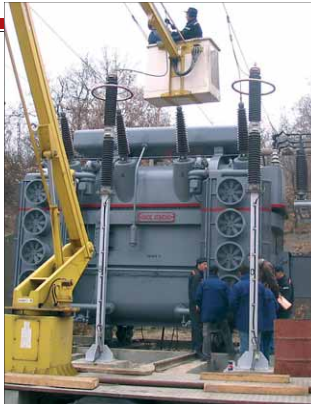
У време монтаже новог трафоа у ТС "Валач"
