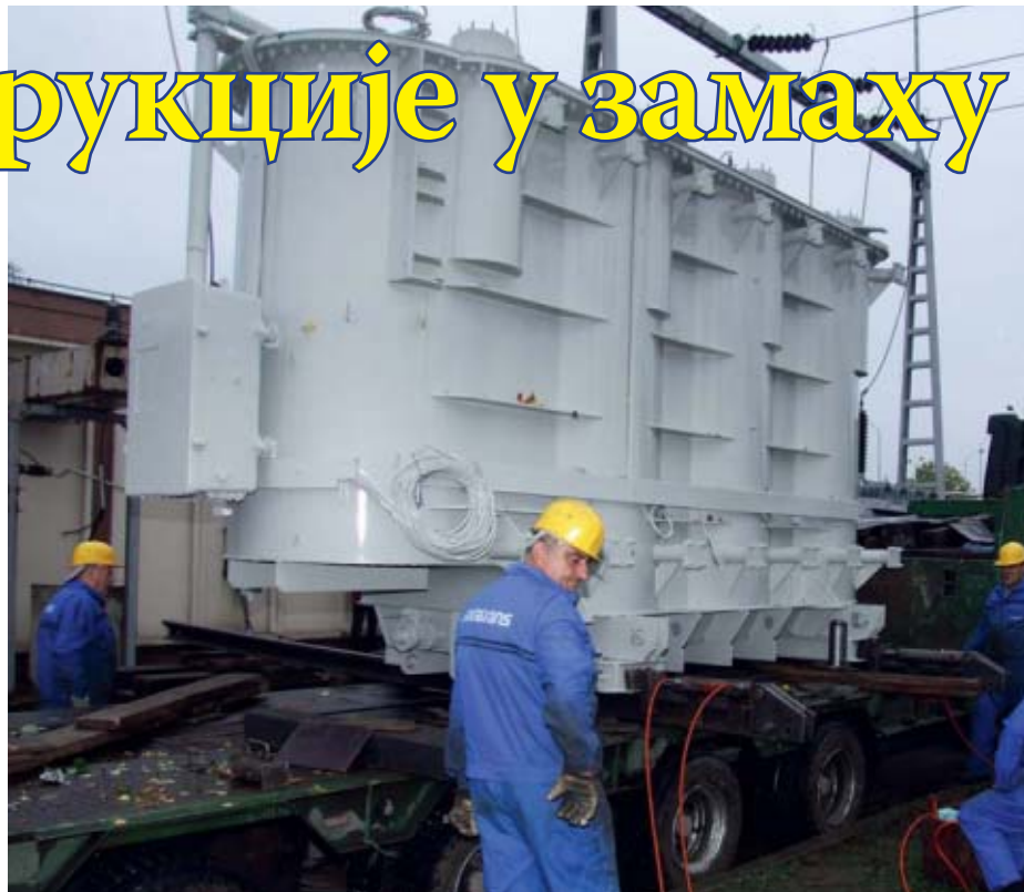
При крају радови на реконструкцији ТС 110/10 „Ниш 10“
