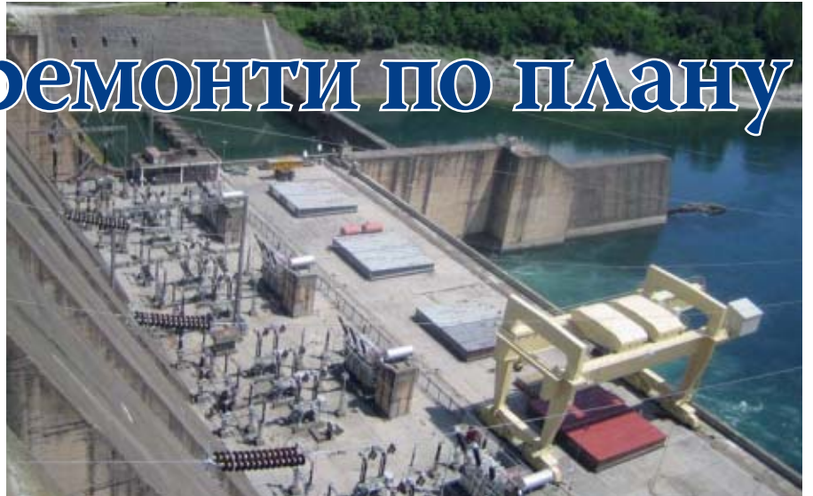
У ХЕ „Бајина Башта“ замењени и прекидачи од 220 kV
